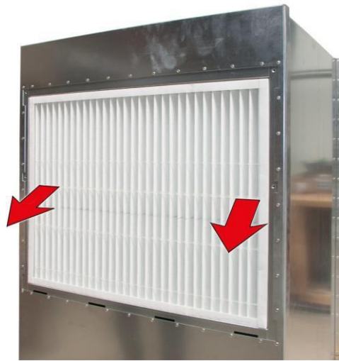
Fig. 9 Remove side prefilter
